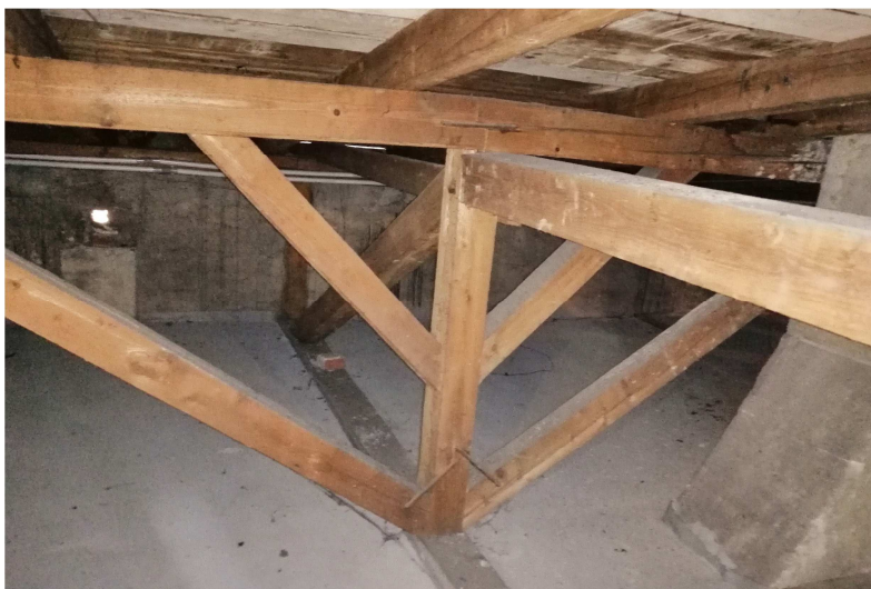
Fot.6 Węzeł podporowy płatwi
