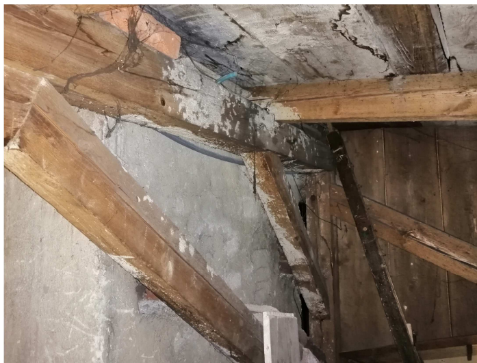
Fot.1 Widok na elementy wschodniej połaci – widoczna zaawansowana korozja biologiczna
