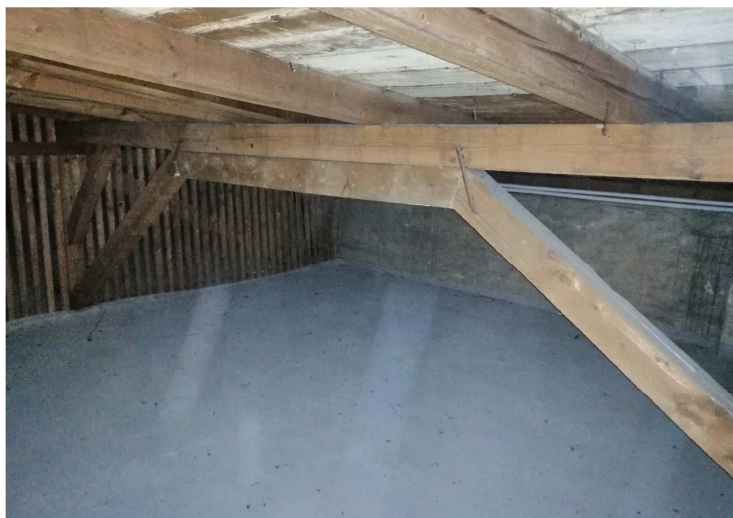
Fot.5 Kozły podporowe dla płatwi pośrednich
