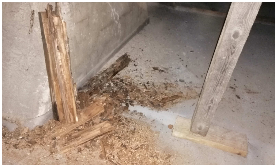
Fot.4 Widok na wschodnią połąć – fragmenty spróchniałych elementów więźby dachowej
