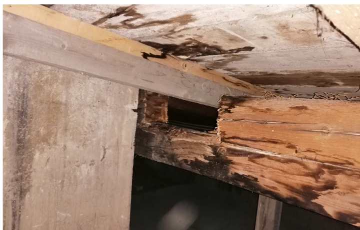
Fot.2 Widok na elementy wschodniej połaci – osłabiony wycięciem przekrój płatwi
